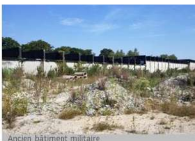
Ancien bâtiment militaire
